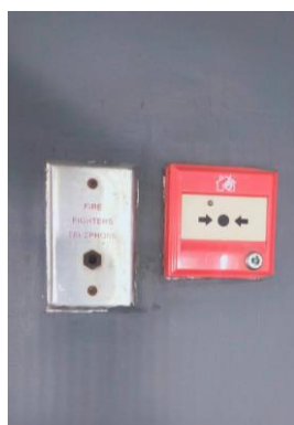
แผงควบคุมระบบแจ้งเหตุอัคคีภัย, เครื่องตรวจจับความร้อน เครื่องตรวจจับควัน , Telephone JACK, เครื่องแจ้งเหตุด้วยมือ
