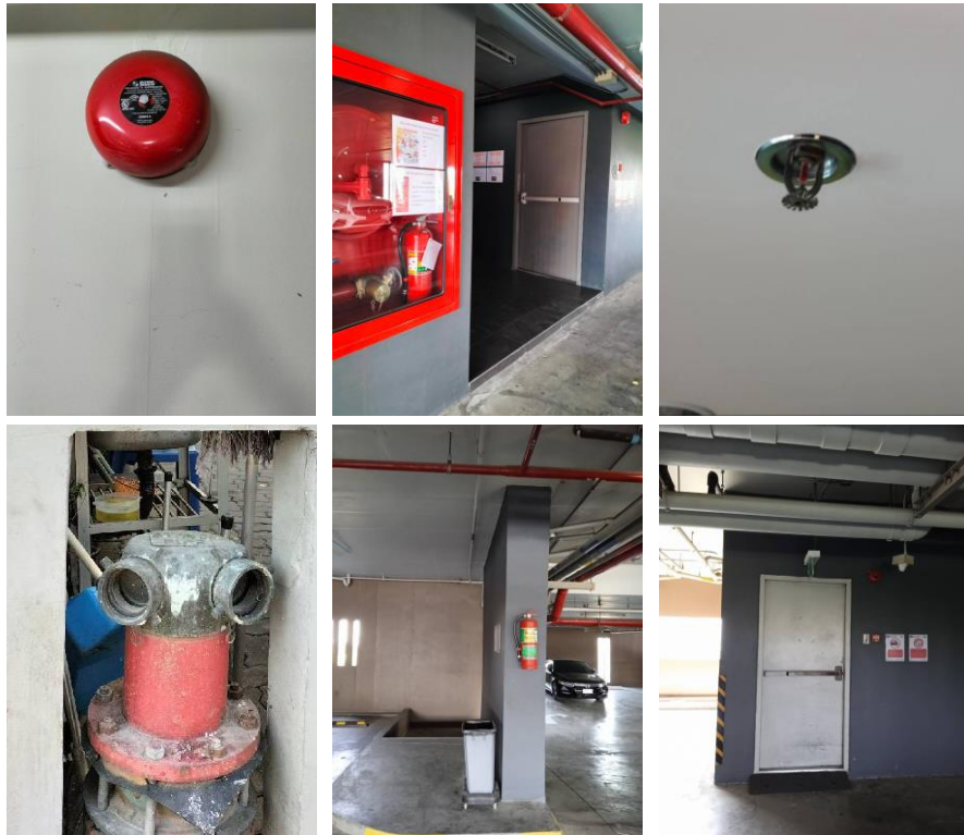
กระดิ่งสัญญาณ , ตู้เก็บสายฉีดน้ำดับเพลิงพร้อมอุปกรณ์และป้ายแนะนำอุปกรณ์ ระบบหัวกระจายน้ำดับเพลิง , หัวรับน้ำดับเพลิง, ถังดับเพลิง, ทางหนีไฟ
