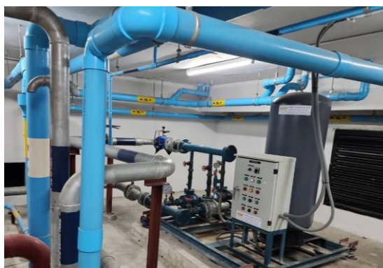
ปั๊ม และถังสำรองเพื่อการอุปโภค-บริโภค (ชั้นดาดฟ้า)
