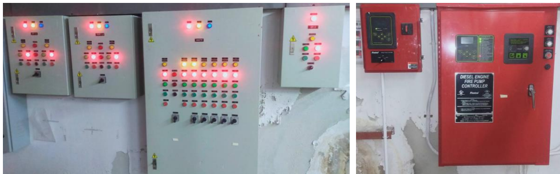
ระบบบำบัดน้ำเสีย , ระบบ Fire Pump
