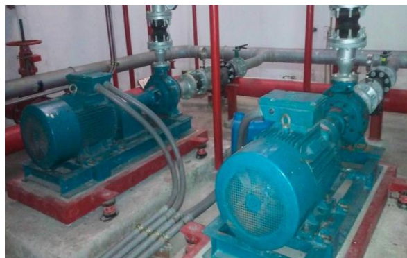
ปั๊ม เพื่อการอุปโภค-บริโภค และดับเพลิง (ชั้นใต้ดิน)
